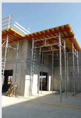
Utilizzabile con puntelli fino all' altezza di 7,25 m.
