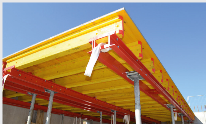
Il puntello si blocca automaticamente grazie ad un sistema innovativo di serraggio a cunei.
