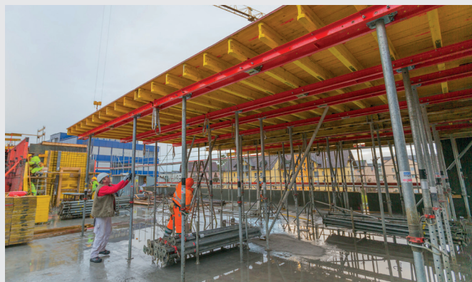
Solo 4 puntelli per ogni tavolo per solette, fino ad uno spessore di 40 cm.
