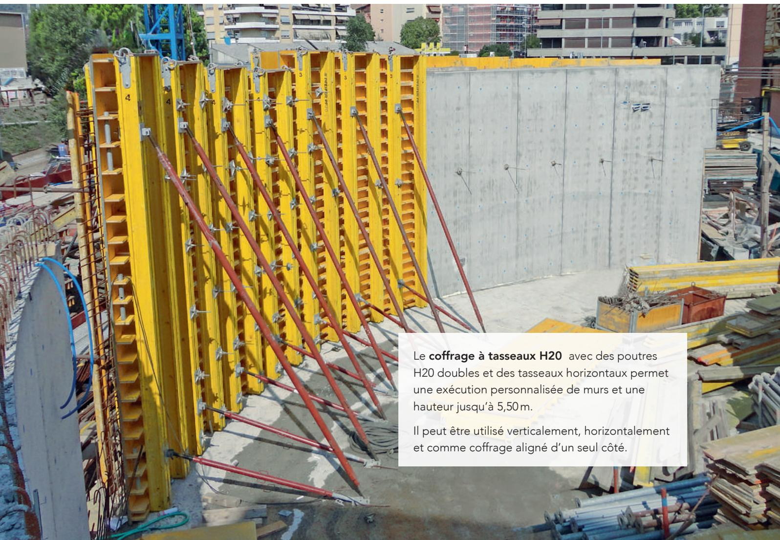
Le **coffrage à tasseaux H20** avec des poutres H20 doubles et des tasseaux horizontaux permet une exécution personnalisée de murs et une hauteur jusqu'à 5,50 m.
