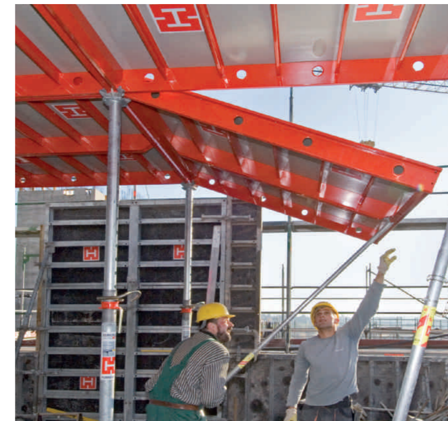
◀ Sicherer Auf- und Abbau vom Boden aus bei Höhen bis 3,50 m in drei leichten Arbeitsschritten. Einfach einhaken – hochschieben – abstützen.
