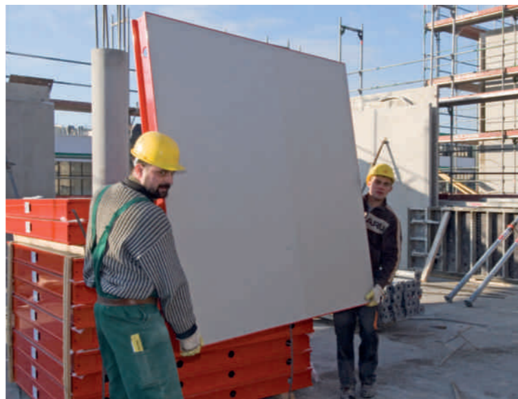
► Die leichte Aluminiumkonstruktion von TOPEC gewährleistet ergonomische und ermüdungsfreie Abläufe.
