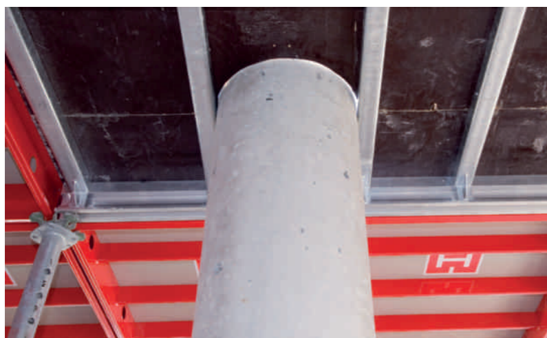
► Säulen und andere Hindernisse lassen sich mit den TOPEC Ausgleichslösungen leicht umgehen.
