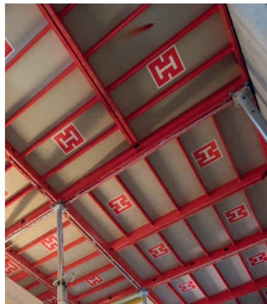
► Diese 180 x 180-Großtafel hat 3,24 m 2 Schalfläche.
