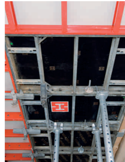
► Einfaches Schalen von Pass- und Ausgleichsflächen mit Kantholzhalter oder RASTO Standardtafeln
