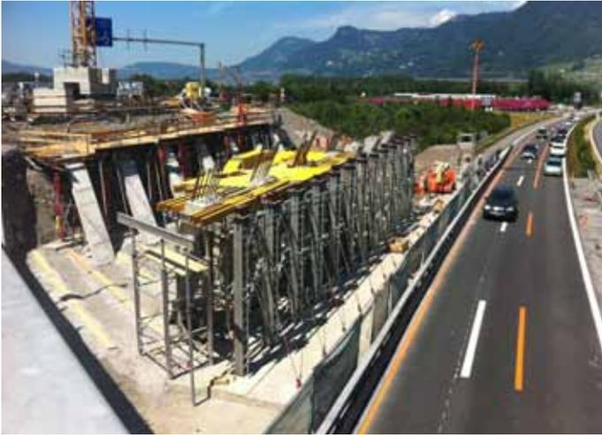
Die Fertigelemente werden mit schräg verlaufenden Ortbetonpfeilern zu einem Unterzug vergossen. Hier profitiert das Baustellenteam vom flexiblen und schnell montierbaren Titan-Traggerüst.
