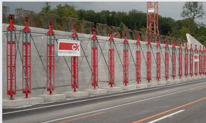
Étagage Peiner pour passerelle d'autoroute
